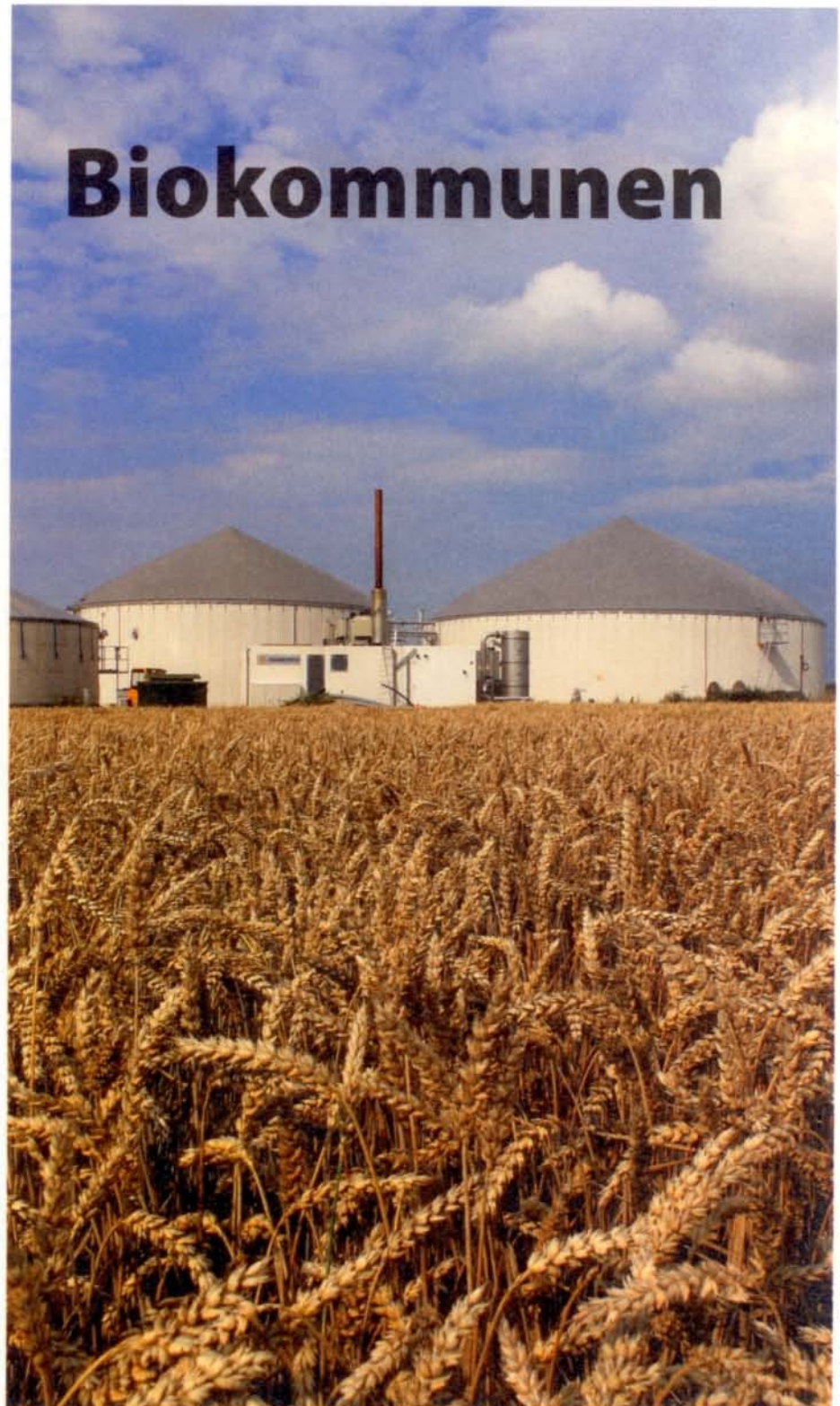
Biomasse vom Acker, wie hier vor einer Biogasanlage in Schleswig-Holstein, steht nicht so hoch im Kurs der Bioenergie-Experten. Angestrebt wird vielmehr eine erschöpfende Ausnutzung der biogenen Reststoffe aus dem Umland sowie der Bioabfälle aus der Lebensmittelproduktion.
